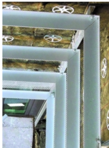
Unterkonstruktion; Innenecke mit einseitiger Tragkonstruktion
